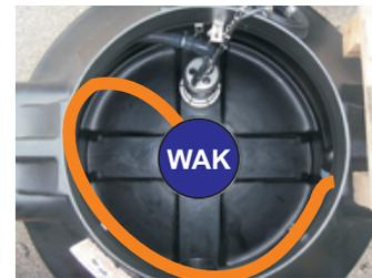
WAK mit Einhebehilfe einsetzen
